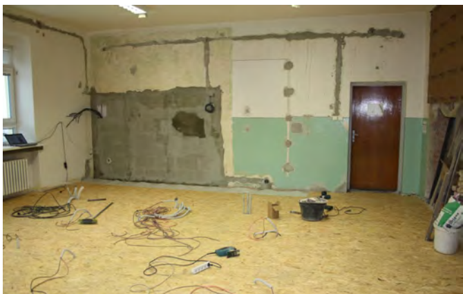
Rekonstrukce učebny fyziky a chemie
