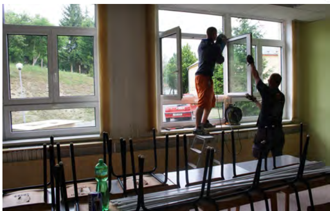
Výměna oken v tělocvičně a v přístavbě
