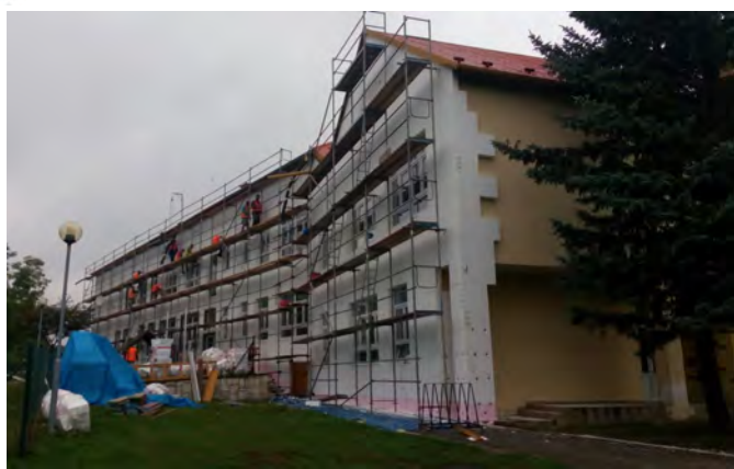
Zateplení a nová fasáda tělocvičny, přístavby
