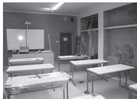
Instalace nového nábytku
