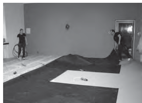
Pokládka nové podlahy
